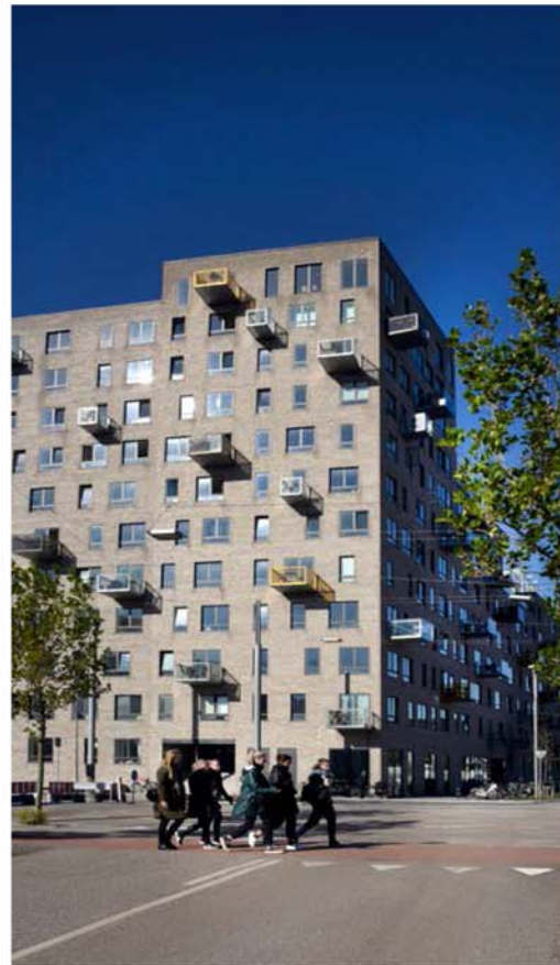
Højeste facade imod Bernhard Jensens Boulevard.
