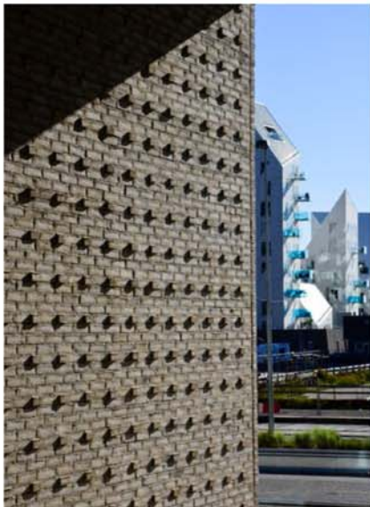
Murstensvæg imod Isbjerget.
